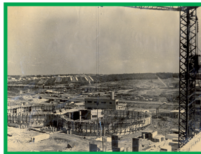
Строительство Березовской ЦОФ. Лето 1965 г.
