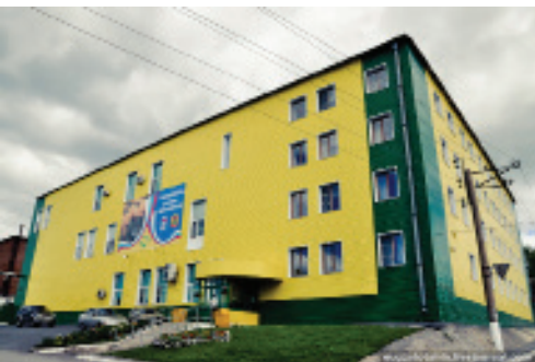
Производственный комплекс «Подорожник» (г. Топки)
